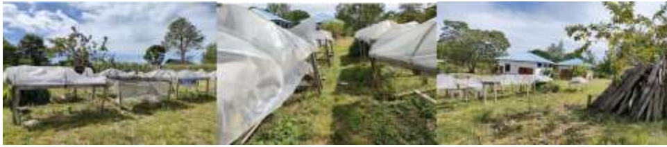
Gambar 6. Pengering Rumah Kaca tidak bisa difungsikan perlu perbaikan
