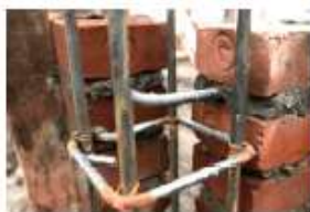
(a) Pemasangan angkur besi sebagai pengikat antar kolom
